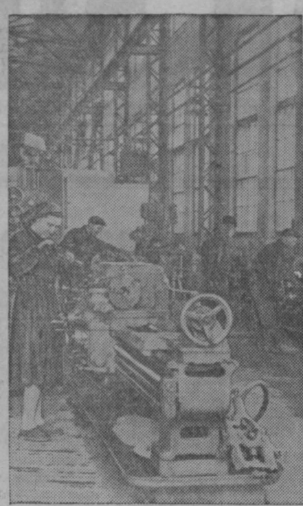
Коллектив стройуправления № 2 треста «Сталкинспромстрой» заканчивает отделочные работы в новом цехе ширпотреба Кузнецкого комбината. На днях механическая мастерская слана в эксплуатацию.
