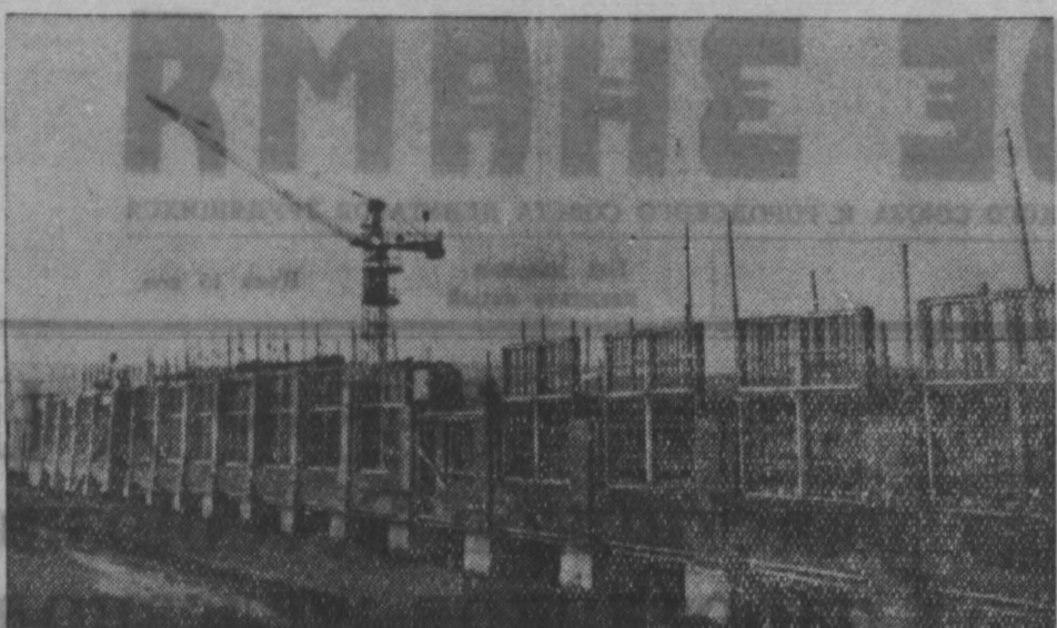
На строительстве новой мебельной фабрики Кузнецкого комбината идет кладка кирпичных стен. Строительство ведет трест «Кузнецктяжстрой». Ежегодно эта фабрика будет изготавливать тысячи шифонеров, столов, стульев, диванов и другой мебели.
