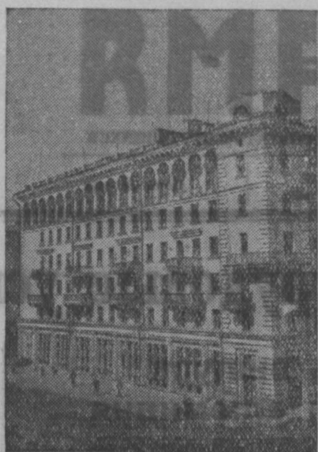
140-квартирный дом по улице Суворова, в благоустроенных квартирах которого живут металлурги Кузнецкого комбината. Фото П. Дуляпина.
