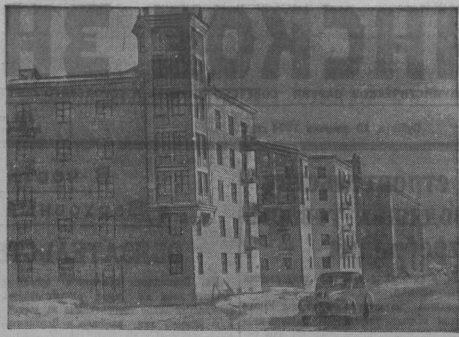
Строительство нового дома для кузнецких металлургов по проспекту им. Куйбышева. Фото Н. Никитина.
