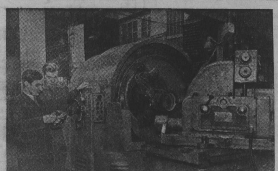
Обработка конических колес спиральными зубьями — одна из наиболее сложных и трудоемких операций. На московском заводе «Станкоконструкция» впервые изготовлен специальный станок-полув автомат для шлифования таких колес. Он работает особыми абразивными кругами. Скорость шлифования достигает 50 метров в секунду.
