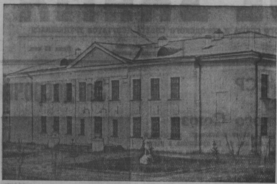
Коллектив треста «Кузнецкстрой» закончил отделочные и планировочные работы на строительстве корпуса 10-й средней школы по улице Обиорского. На днях это здание принято в эксплуатацию государственной комиссией.
