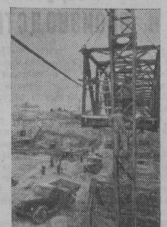
Строители Каховского гидроузла по уплотненному гравику производят укладку бетона в блоки камеры шлюза. Уже уложены сотни кубометров бетона. Монтажники сооружают бетоноукладочный мост, который даст возможность в несколько раз ускорить процесс работы.
