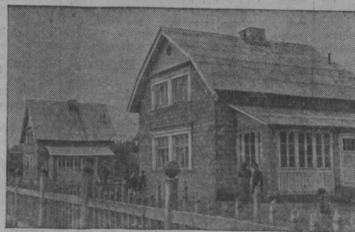
Московская область. В Мытищинской МТС проводится большое строительство. Сооружаются мастерская, котельная, контора, общежитие и жилые дома.
