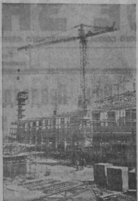
Львовская область. В Красненском районе идет строительство крупного сахарного завода.
