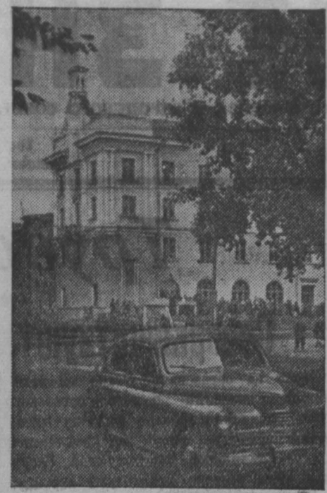
Благоустроивается шахтерский поселок Куйбышев. Здесь строятся новые дома, школы и другие культурно-бытовые здания. На снимке: новый дом на улице 1 Мая. Фото П. Дулянского.
