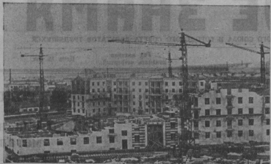
На снимке: на строительной площадке 220-квартирного жилого дома в районе «Сталинского». Сооружение дома осуществляется строительным управлением № 1 треста «Сталинскстрой».
