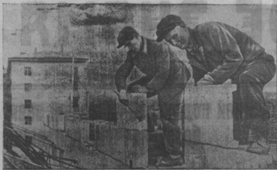
По-стахановски трудится бригада каменщиков тов. Талдышева в строительном управлении № 1 треста «Сталкспромстрой». Особенно отличился в работе каменщик тт. Рузаев и Ефимов. Они выполняют по 180—185 процентов нормы. На снимке: стахановцы тт. Рузаев и Ефимов за облицовкой нового жилого дома. Фото П. Дулянского.
