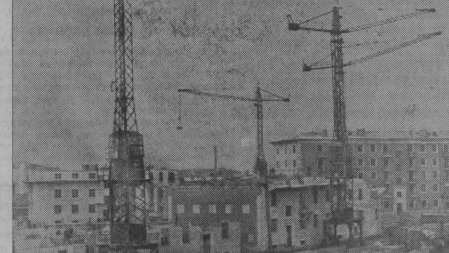
Башенные краны на строительстве нового 225-квартирного дома на «треугольнике».
