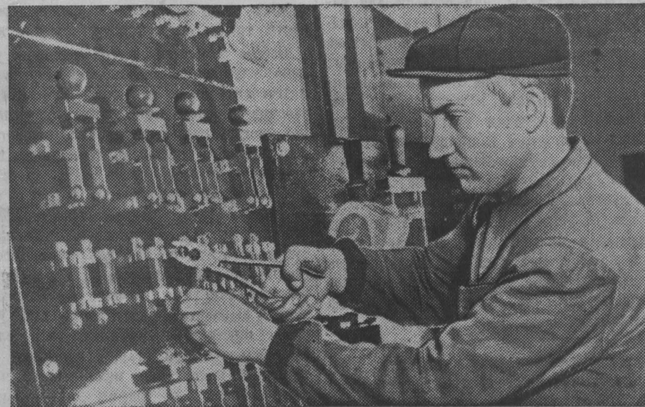
Высокопроизводительно трудится электрослесарь электромонтажного цеха Кузнецкого комбината тов. Сирота. Он систематически выполняет по 170—180 процентов нормы. В настоящее время стахановец работает в счет 1955 года. На снимке: т. Сирота М. В. за работой.
