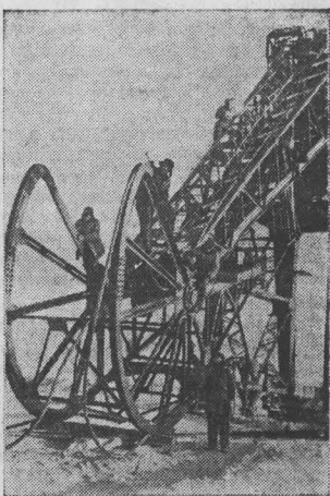
Куйбышевгидрострой. На строительномонтажных площадках великой стройки коммунизма на Волге идет монтаж и сборка оборудования, машин и механизмов, прибывающих сюда непрерывным потоком со всех концов Советского Союза.
