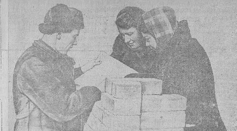
На строительстве домов 4-го стройуправления треста «Сталинскпромстрой». На снимке (слева направо): мастер Л. Андросенков и студенты 4-го курса строительного техникума В. Шишкова и Е. Лоншакова на производственной практике. Фото Н. Никитина.
