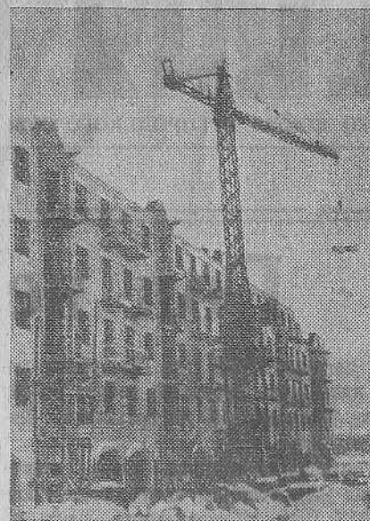
Коллектив строительного управления № 4 треста «Сталинскпромстрой» заканчивает кирпичную кладку многоквартирного жилого дома в районе «треугольника».
