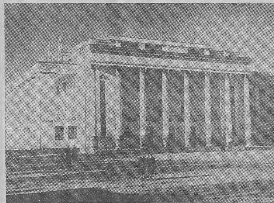
Брянская область. Новый Дом культуры Брянского паровозостроительного завода — одно из лучших зданий в гор. Бежице. Зрительный зал рассчитан на 950 мест, имеется лекционный зал, комнаты для кружков и библиотека.
