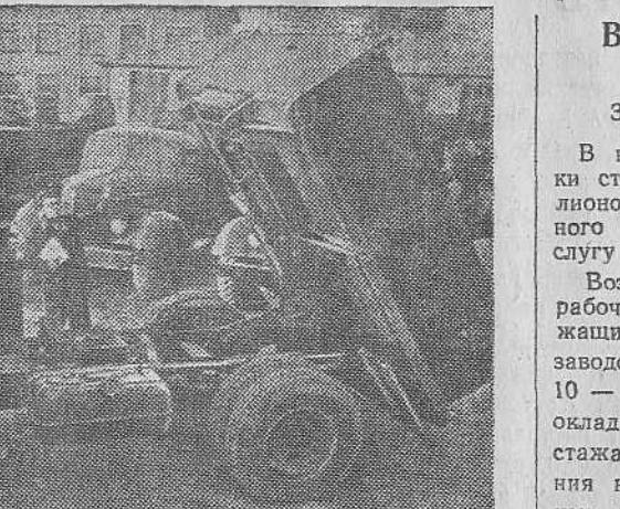
На Московском экспериментальном механическом заводе начат серийный выпуск автоконтейнеров. Эти машины находят широкое применение на строительных и заводских площадках для транспортирования кирпича. С помощью специально установленного опрокидывающегося кузова полностью механизируется процесс погрузки и разгрузки кирпича.
