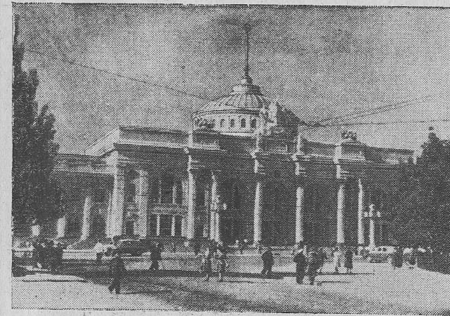
Одесса. Здание нового железнодорожного вокзала. Вид со стороны Привокзальной площади.
