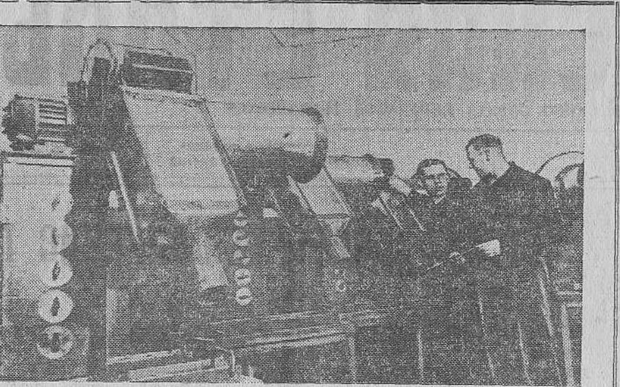
ЛЕНИНГРАД. Завод «Лифтстроймеханизатор» освоил производство аппаратов для борьбы с жучком и домовым грибком в деревянных конструкциях. Вредители уничтожаются воздухом, нагретым до высокой температуры.
