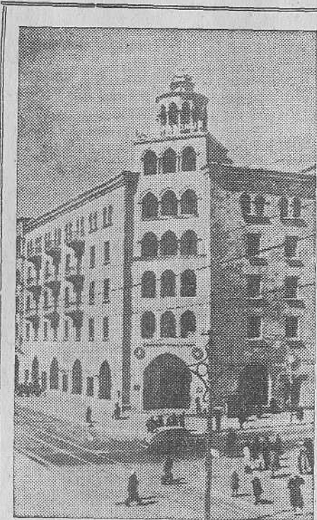
Баку. Жилой дом «Мингечаурстроя» по улице Басина. Главный фасад здания. (Проект архитекторов Г. М. Ализаде М. М. Мадатова). Фото Ф. Шевцова.
