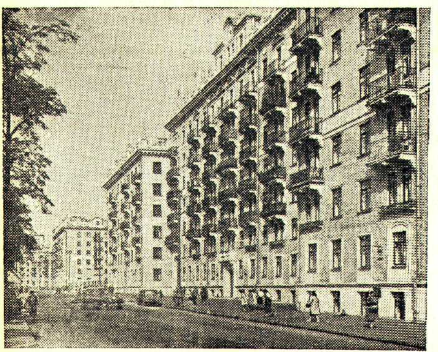
Москва. На Ново-Песчаной улице развернуто большое строительство многоэтажных жилых домов. Строительство полностью механизировано и ведется из однотипных строительных и архитектурных деталей. На снимке: новые многоэтажные жилые дома на Ново-Песчаной улице. Фото Н. Грановского. (Фотохроника ТАСС).
