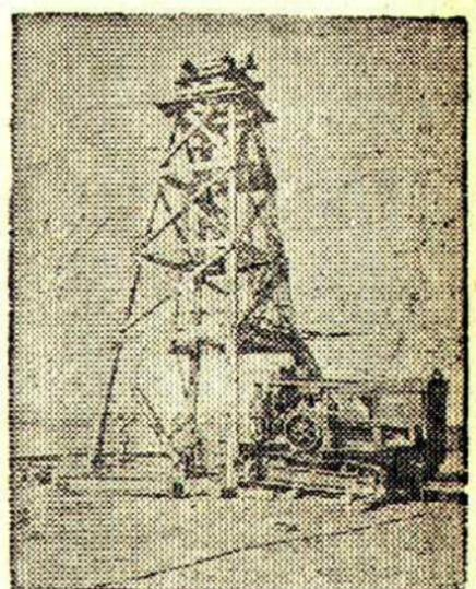
Сталинградгидрострой. На Калачевском строительном участке бурится несколько артезианских скважин для снабжения питьевой водой нового города строителей, сооружаемого на левом берегу Волги. На снимке: бурение артезианской скважины при помощи бурового станка «Урален». Фото А. Маклецова. (Фотохроника ТАСС).
