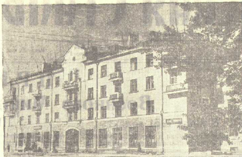
Вновь выстроенный многоэтажный дом для работников треста «Сталинскпромстрой» в районе деревообделочного завода.
