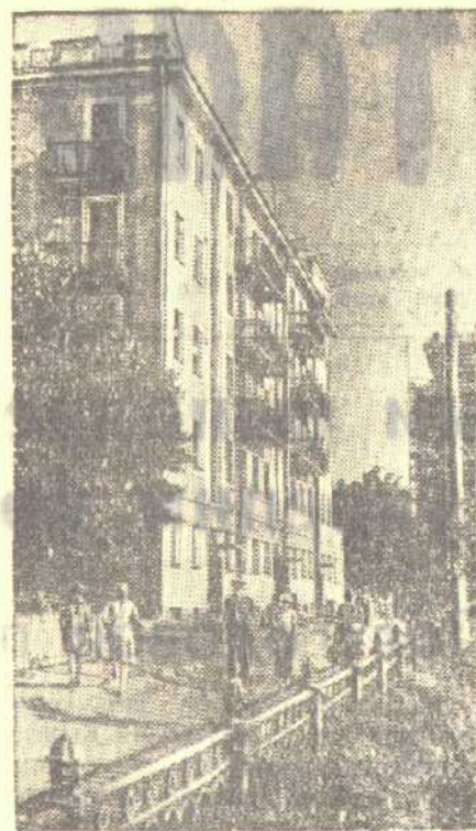
На снимке: дом № 7 по улице Кирова. Фото Н. Никитина.
