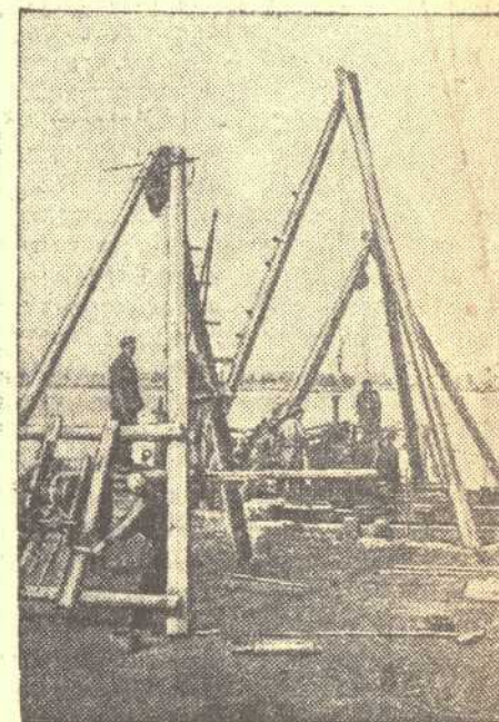
Геологические изыскания на месте, где будет сооружена плотина Каховской ГЭС. На снимке: буровой станок старшего мастера И. И. Кочергина за работой.
