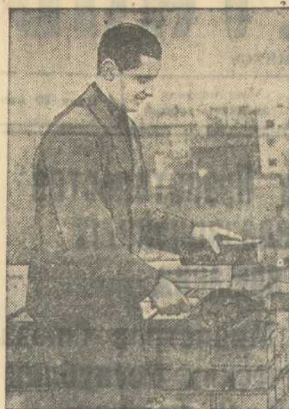
Каменщик-комсомолец 4-го стройуправления треста «Сталинскпромстрой» П. Москалев. На кладке многоэтажных домов он свое сменное задание выполняет на 150—180 процентов. На снимке: каменщик тов. Москалев за работой.
