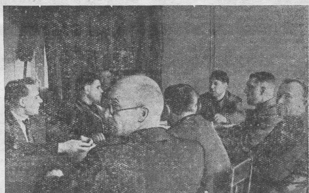
На очередном рапорте руководители и прорабы ремонта второй доменной печи обсуждают готовность печи к постановке на сушку. Фото Н. Никитина.
