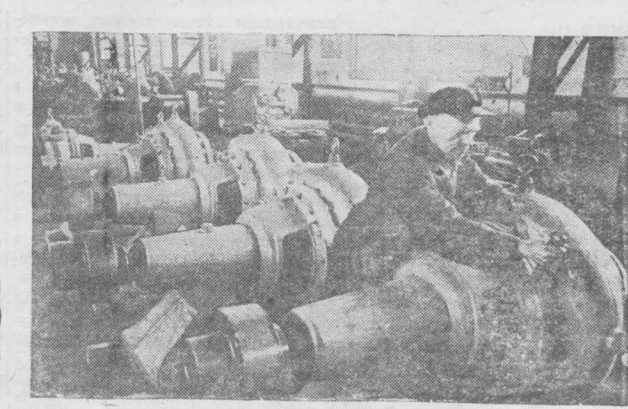
Свердловск. Уральский завод гидромашин освоил выпуск центробежных насосов различных типов для водоснабжения городского хозяйства восстанавливаемых областей. На снимке: старейший рабочий Н. А. Теткин за сборкой насосов. Фото Б. Мясникова.
