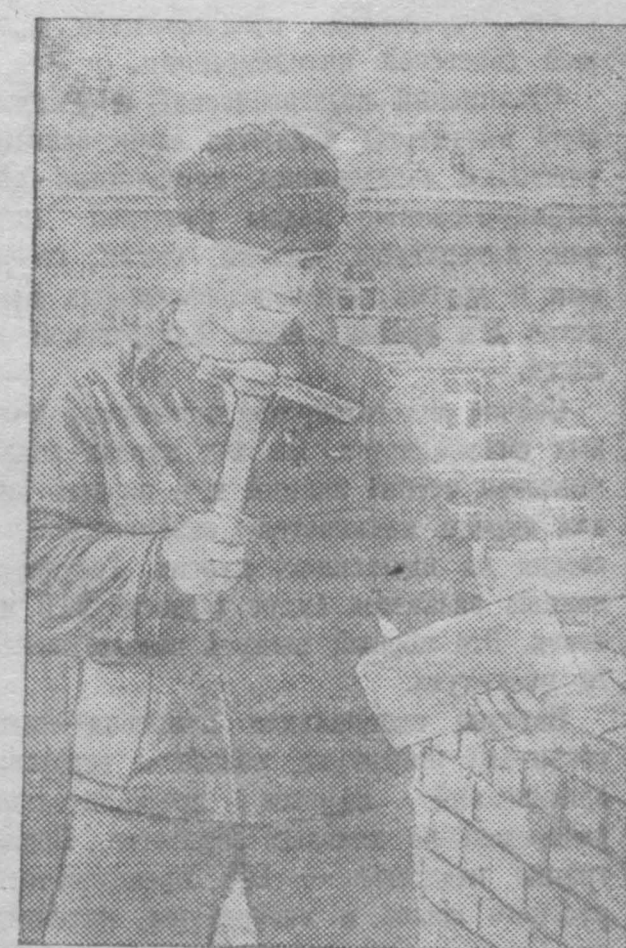
Знатный каменщик 4-го стройуправления треста «Сталинсктрестрой» М. В. Старцев. По итогам работы за январь и февраль месяцы т. Старцеву присвоено звание лучшего каменщика треста. На снимке: т. Старцев за работой.
