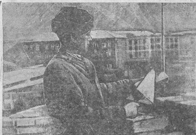
Лучший каменщик 1-го стройуправления треста «Сталинскстрой» Александр Жданов. Он ежедневно выполняет норму извлеченной породы на 170—200 процентов. На снимке: Александр Жданов за работой. Фото Н. Никитина.
