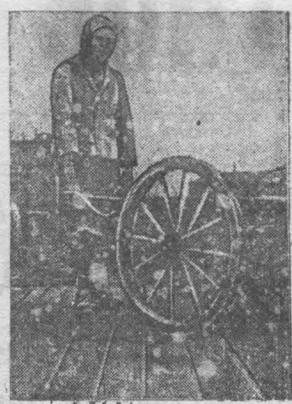
Работница 4-го строуправления треста «Сталинскострой» Н. В. Козлова. На строительстве жилых домов она бесперебойно обеспечивает материалами каменщиков. На снимке: г. Козлова за работой.
