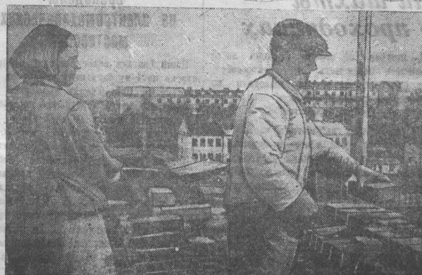
Лучший каменщик стройуправления № 1 треста «Сталинскстрой» тов. Лазаренко А. А. на строительстве 140-квартирного дома систематически выполняет норму на 170 процентов. На снимке: каменщик тов. Лазаренко и подручник тов. Менашева за работой.
