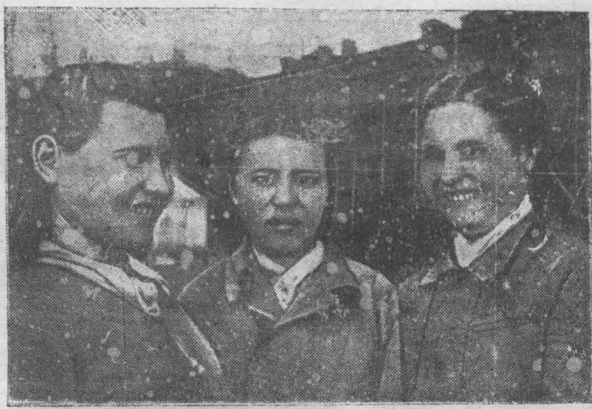
Молодые штукатуры треста «Сталинскпромстрой» на строительстве жилых домов для металлургов по Ворошиловскому шоссе добились высоких показателей. Изюм дня в день они выполняли нормы на 130—140 процентов. На снимке: стахановцы штукатуры (справа налево) Наташа Отыня, Маша Шмакова и Аня Исакова.
