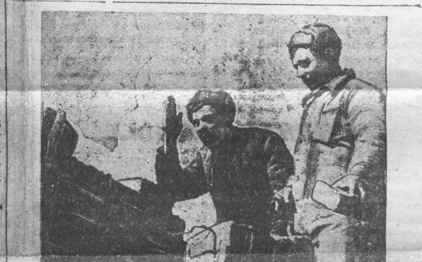
Инженер-прораб строительства Н-ского завода В. А. Осипов дает указания каменщику стахановцу А. С. Щербатову о методах скоростной стройки. Фото Г. Аракеляна.
