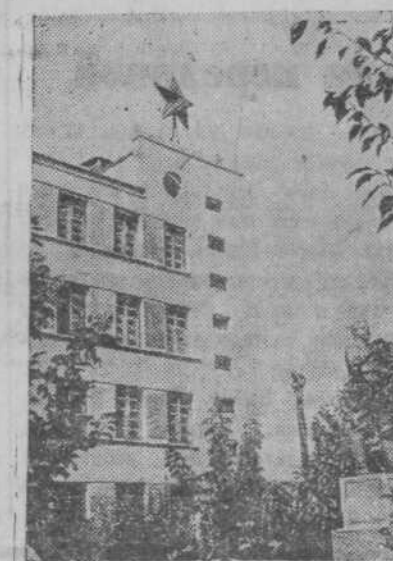
Здание Сибирского металлургического института после ремонта (г. Сталинск).
