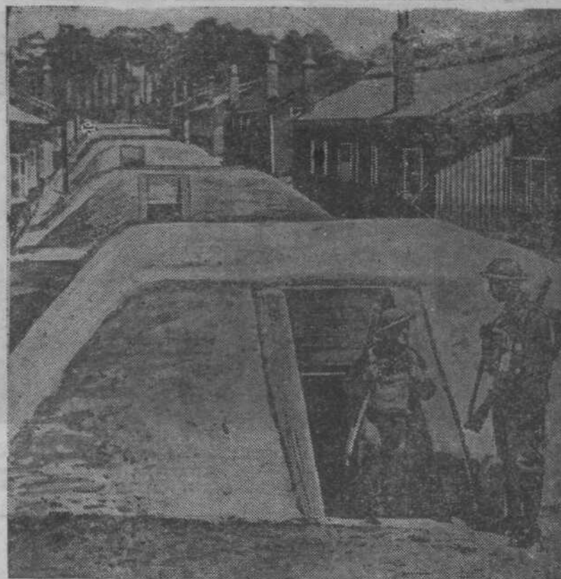
В крупнейшем английском военном лагере Альдершот, в котором находятся 40.000 солдат, сооружено свыше 1000 специальных железобетонных убежищ для защиты личного состава во время воздушных нападений. НА СНИМКЕ: убежища в лагере Альдершот (Англия).
