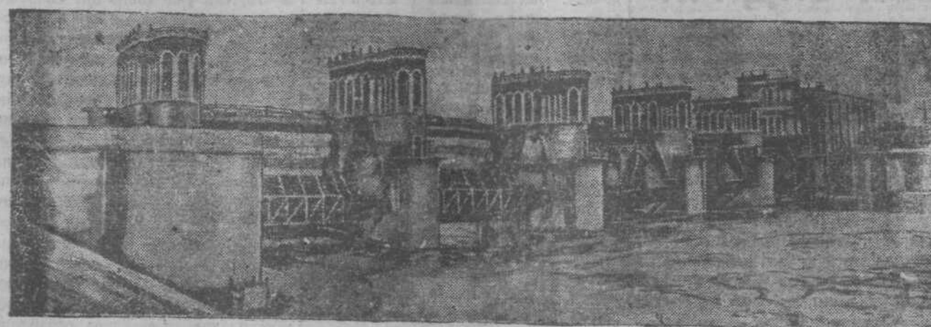
На снимке: общий вид на Карамышевскую плотину с нижнего бьефа.
