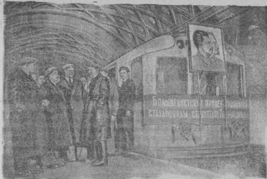
3 ноября по законченному строительству пути Покровского радиуса Московского метрополитена второй очереди прошел первый пробный поезд метро по новой линии, соединяющей центр города с Курским вокзалом. На снимке: первый поезд метро на станции «Курский вокзал». Союзфот.
