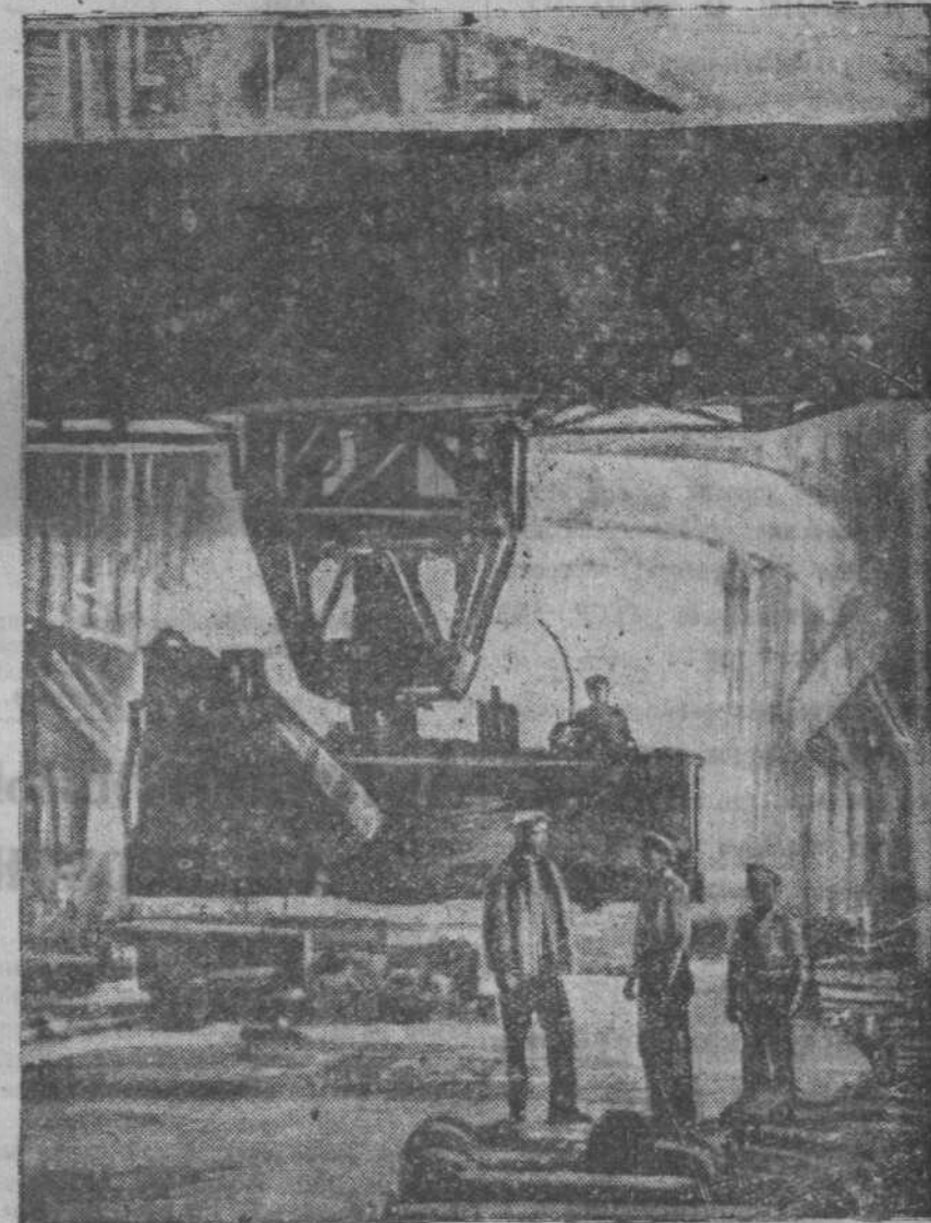
Запорожский металлургический завод «Запорожсталь». На снимке: сталеплавильный цех. Фото Ф. Кислова (Союзфото).
