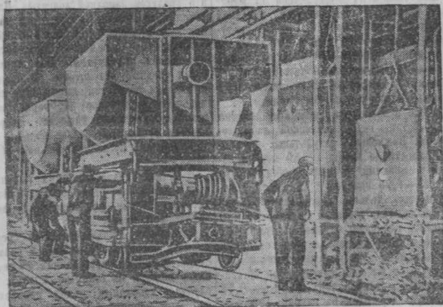
Заправка мартеновской печи магнезитом с помощью заправочной машины.
