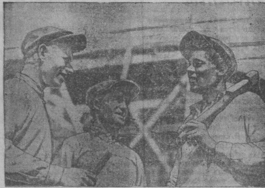
Стахановское звено плотников на строительстве дома связи систематически выполняет план на 150—170 проц. На снимке (слева направо): И. Локтев (бригадир), И. Драчев и П. Кривенко совещаются перед началом работы. Фото М. Демидова.
