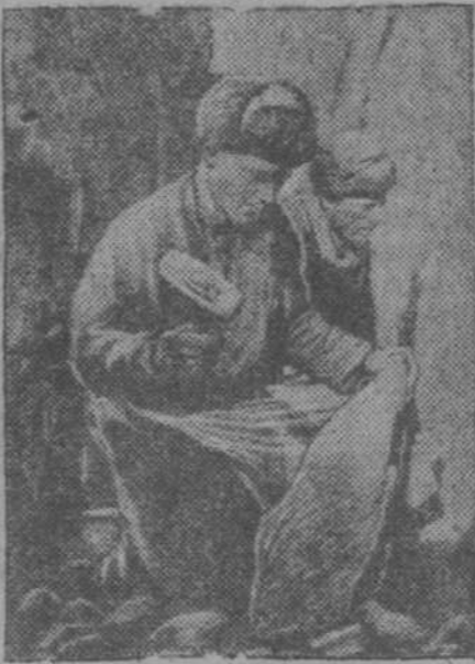
Стахановцы — заменники горелотресты гл. Кулаков и Собачкин закладывают фундамент для строительства новой школы № 8 (Садгород).
