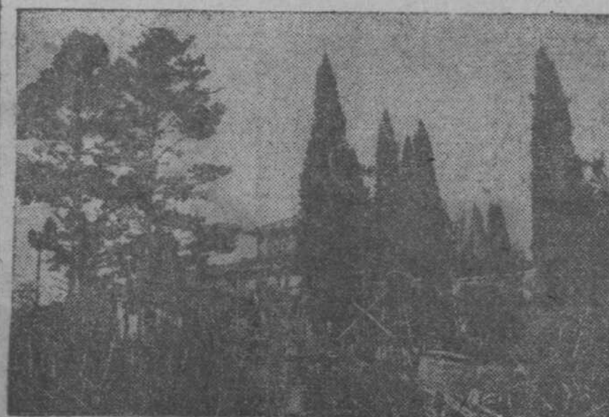
Строительство дома писателя-орденоносца Николаю Островскому в Сочи вчерашне закончено. Сейчас ведутся работы по внутреннему отделке комнат. НА СНИМКЕ: вид с моря на дом-писателя Островского.
