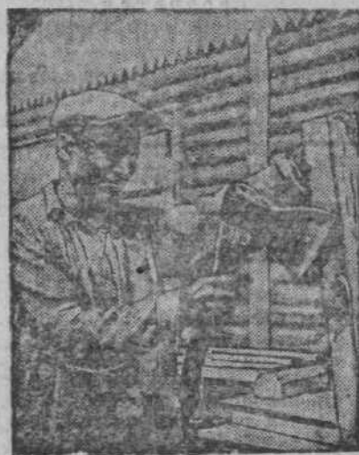
На строительстве технической станции Осинковского рудника. Стахановец плотник т. Черепанов за работой. (Фото Войлокова).
