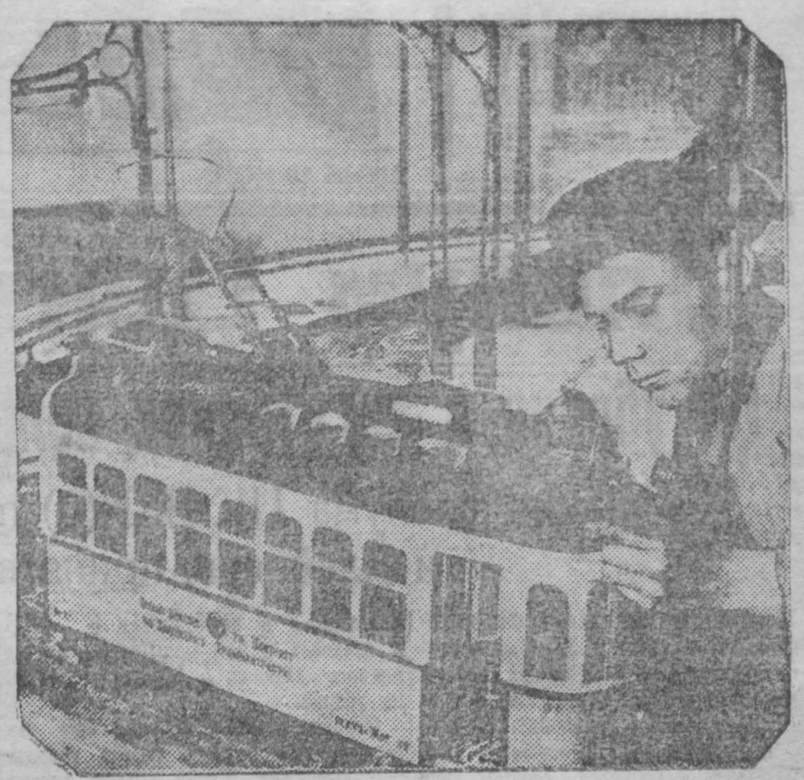
На строительстве Дворца пионеров и октябрят в г. Харькове заканчивается монтаж лабораторий городского транспорта. Здесь дети получают возможность видеть различные модели и механизмы в разрезе и запомнить с их работой. НА СНИМКЕ: монтаж макета трамвайной линии.
