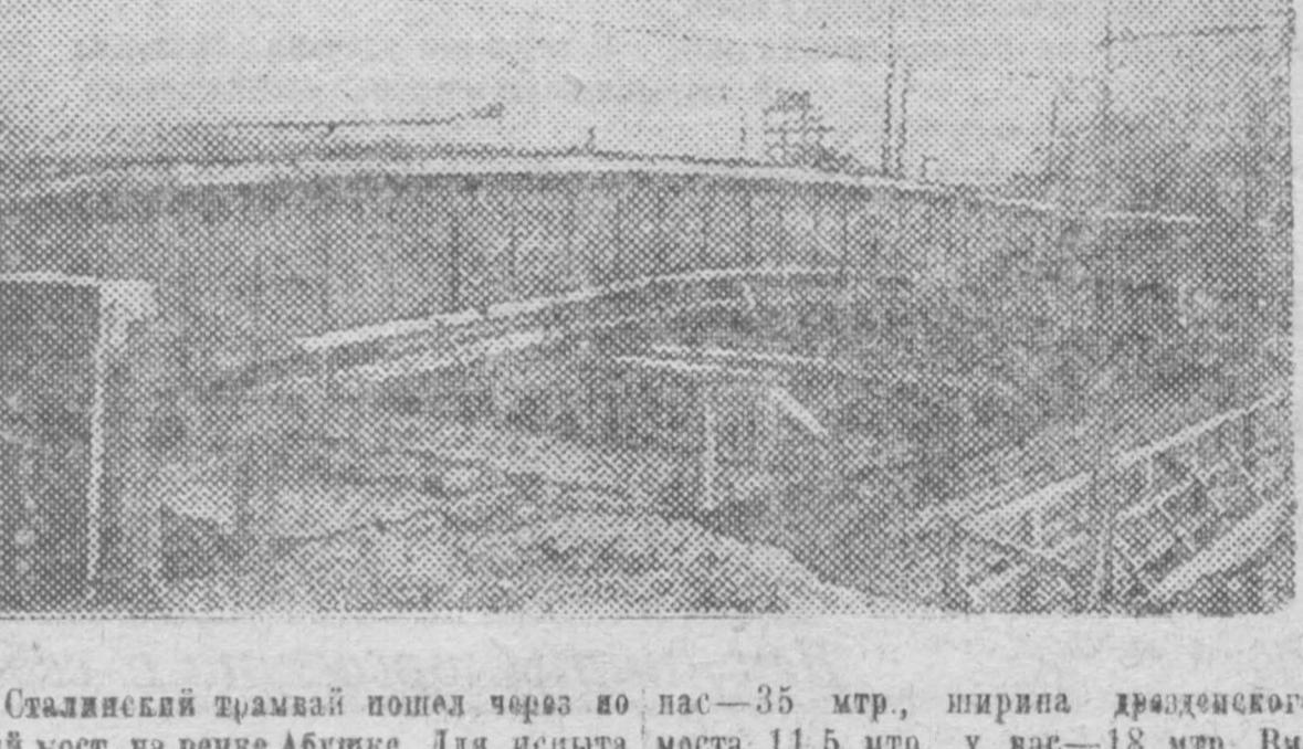
Сталинский трамвай пошел через новый мост, на речке Абушке. Для испытания моста его нагружали в 1,3 раза больше расчетной нагрузки. Мост выдержал испытание.
