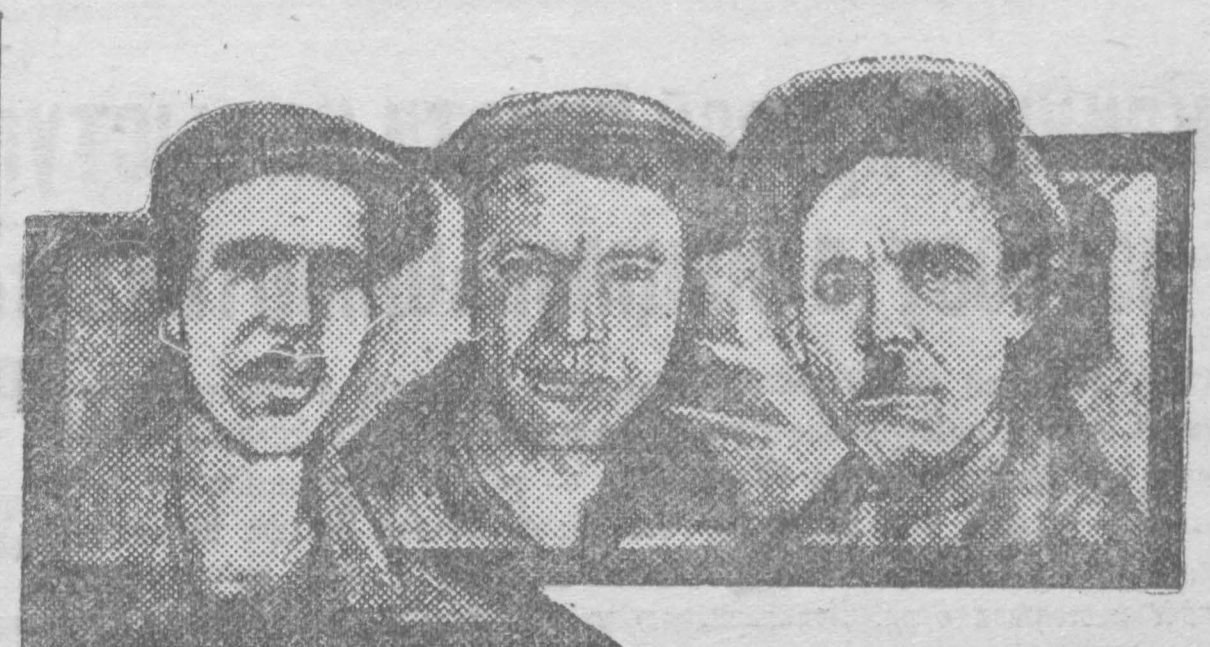
Лучшие ударники строительства соцгорода. Слева направо: бригадир Феофилакт, десятник Бурдаков и штукатуры Карасев.
