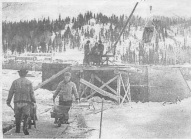
На строительстве «быков» на реке Мрассу.
